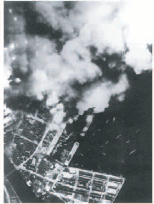
福岡大空襲(昭和20年)6月19日深夜、米軍爆撃機の大編隊によって大被害。写真は米機撮影の炎に包まれる奈良屋方面。この下に逃げかどう市民が被災6万余人。※「ふるさと100年」(福岡市)より
